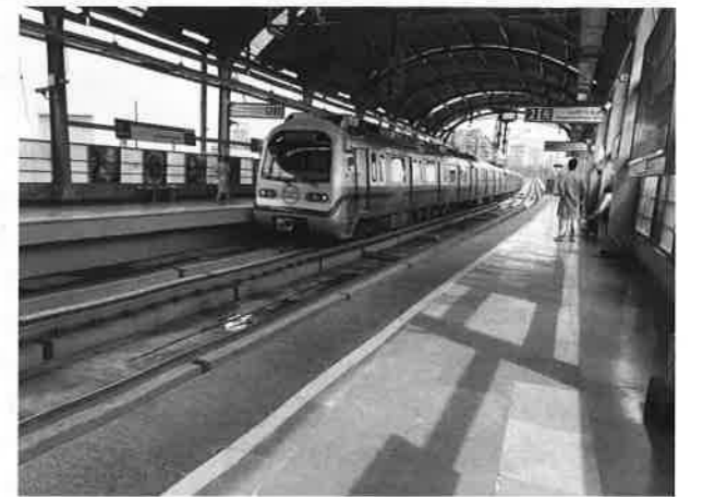
▲日本のODAにより建設されたデリーメトロ
