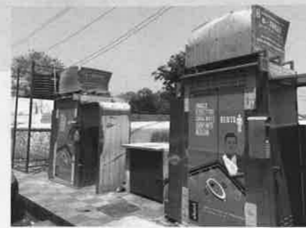
▲クリーン・インドの一環で作られた公衆トイレ
